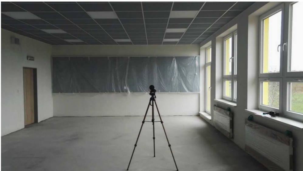
Obr. 9: Ukázka instalace zvukově pohltivého podhledu Sonit SP5V se speciální úpravou zadní strany na ½ plochy
