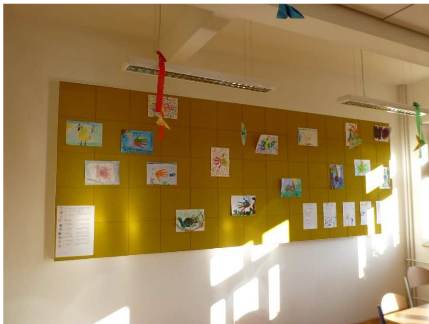
Obr. 8: Ukázka instalace zvukově pohltivého stěnového obkladu Sonit D30V na zadní stěně učebny
